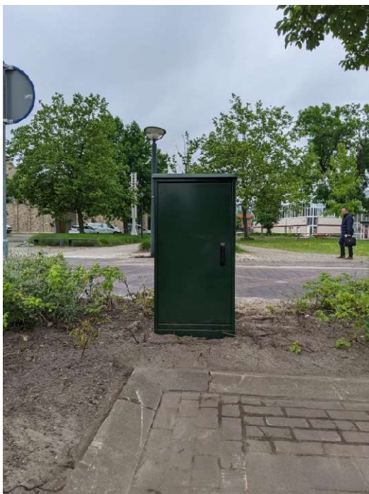
Huis voor Cultuur en Bestuur Hoogezand, 5 EV laadpunten + onderverdeling 100A (in veldkast)
